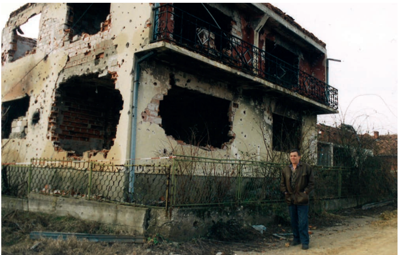
Rückkehr nach dem Krieg in das eigene Haus: Mann steht vor seinem Haus, das völlig zerstört ist, Nordbosnien (1995), Hilfe konkret / Croatian Baptist Aid (CBA)
